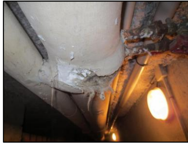
Photo N° 1061 ECH-N°2 CALORIFUGEAGE --COULOIRS DE CAVES Conduits de fluide Laine minérale + enveloppe plâtrée
